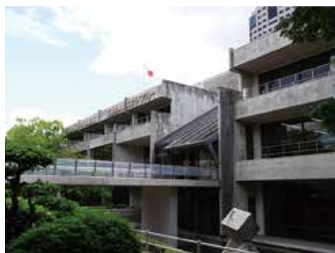
現在の外観 北側
