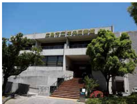
現在の外観 南側
